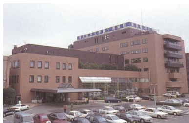
平成9（1997）年12月 外来本館棟（左）、東館病棟（右）
